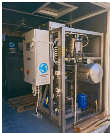
蒸發試驗設備
