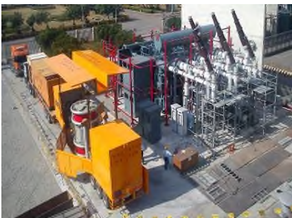
電力電纜交流耐電壓試驗 AC Withstand Voltage Test on Power Cables
