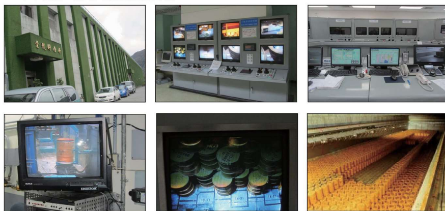
核電廠現代化倉庫的外觀、控管及內部貯存情形圖
