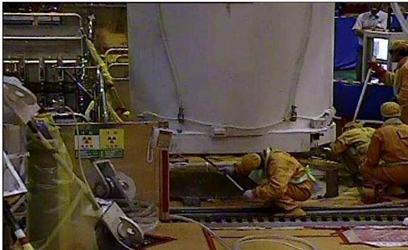
圖 49 傳送護箱底部擦拭除污
