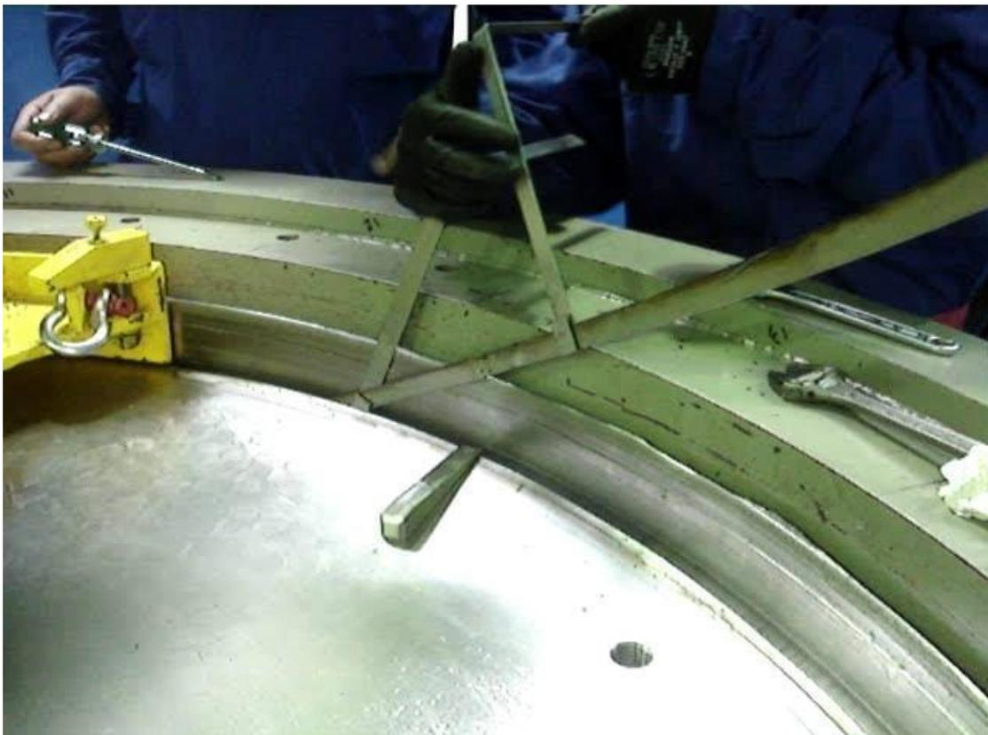
圖 41 屏蔽上蓋墊片取出作業
