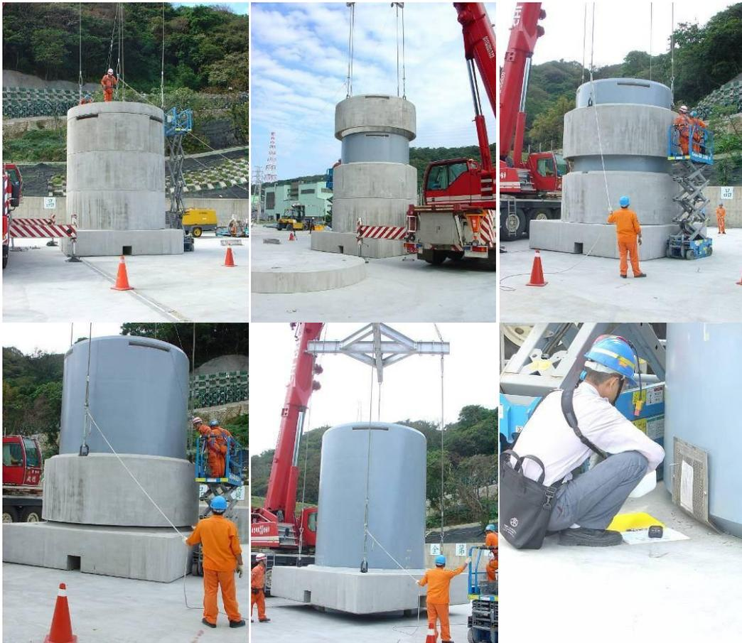
圖 3 吊離外加屏蔽進行輻射偵檢
