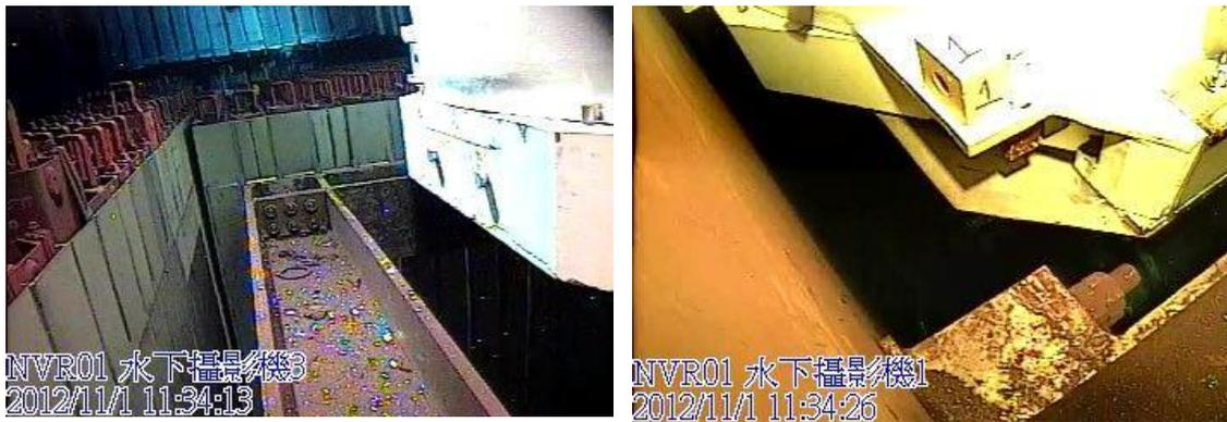
圖 45 傳送護箱底部通過裝載區框架
