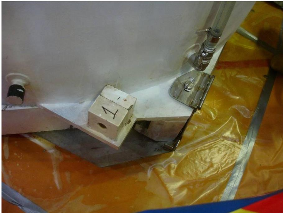
圖 43 傳送護箱底部防污板安裝完成貌
