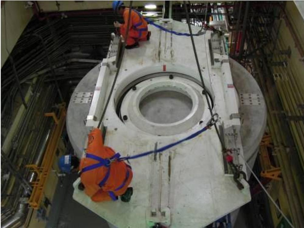
圖 14 於混凝土護箱上安裝銜接器
