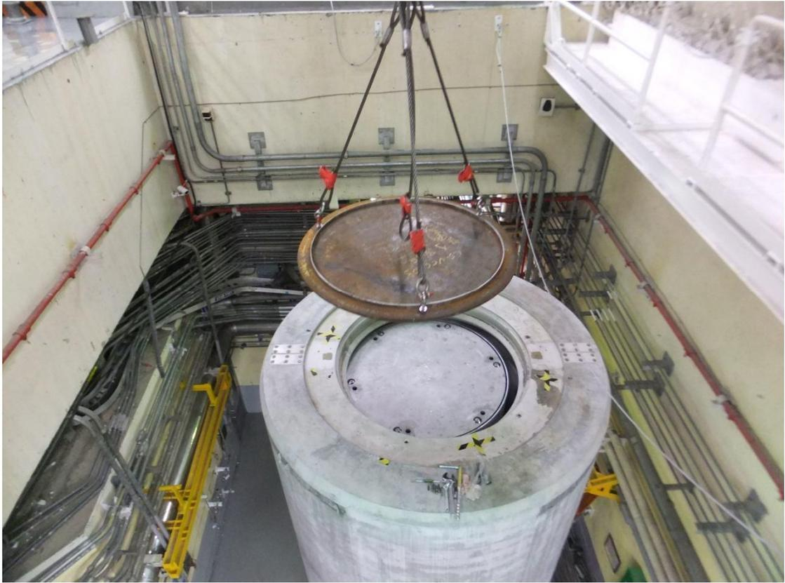
圖 12 混凝土護箱之屏蔽塞吊離
