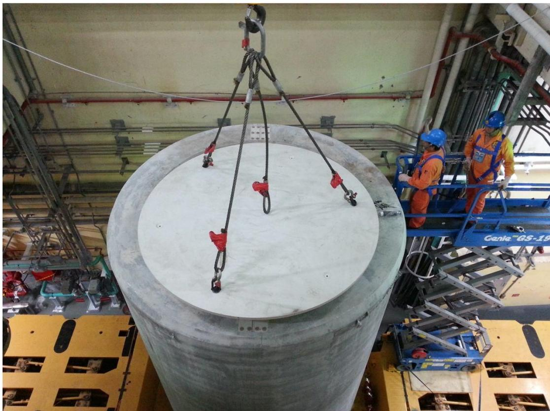
圖 11 將混凝土護箱之頂蓋吊離
