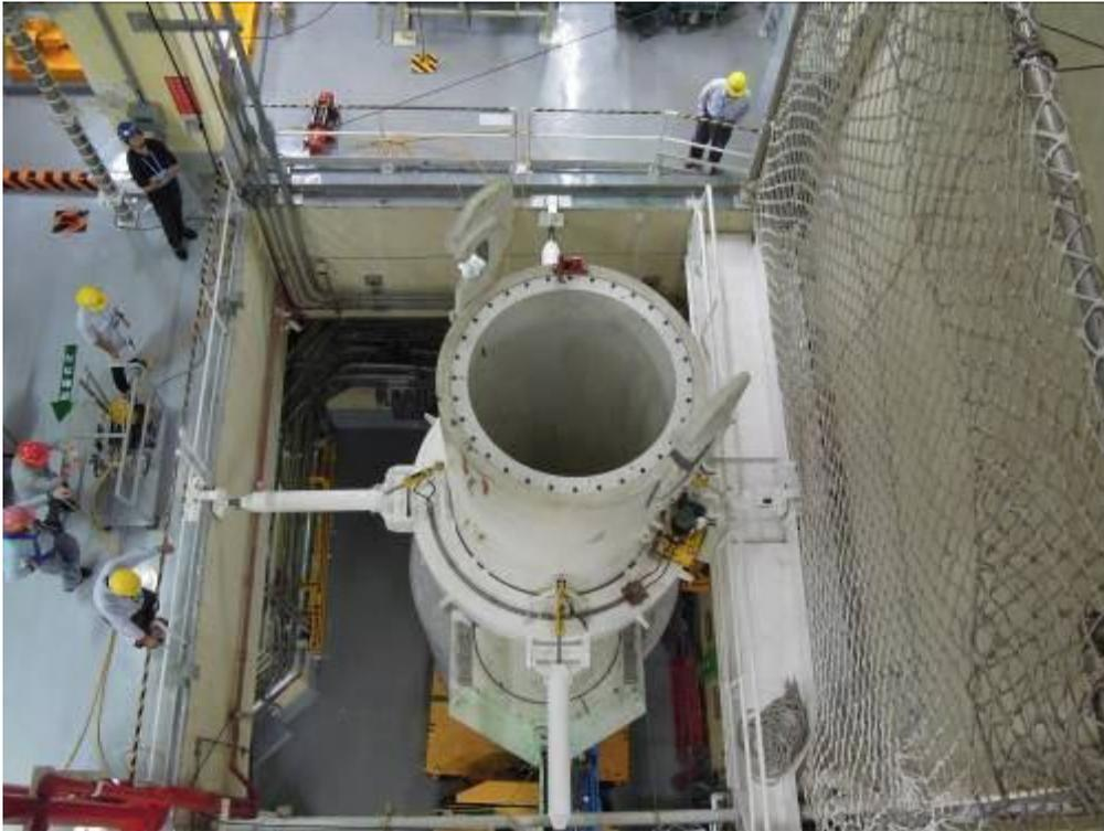
圖 16 傳送護箱座妥後放下 2 樓防震裝置
