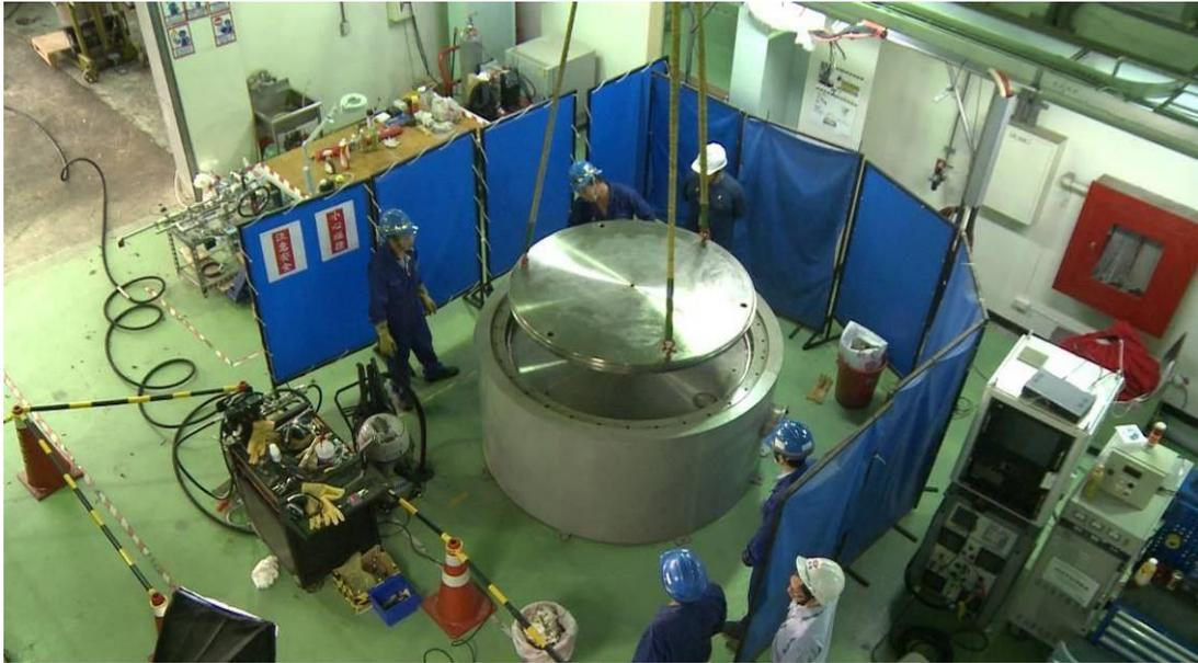
圖 26 結構上蓋成功吊離
