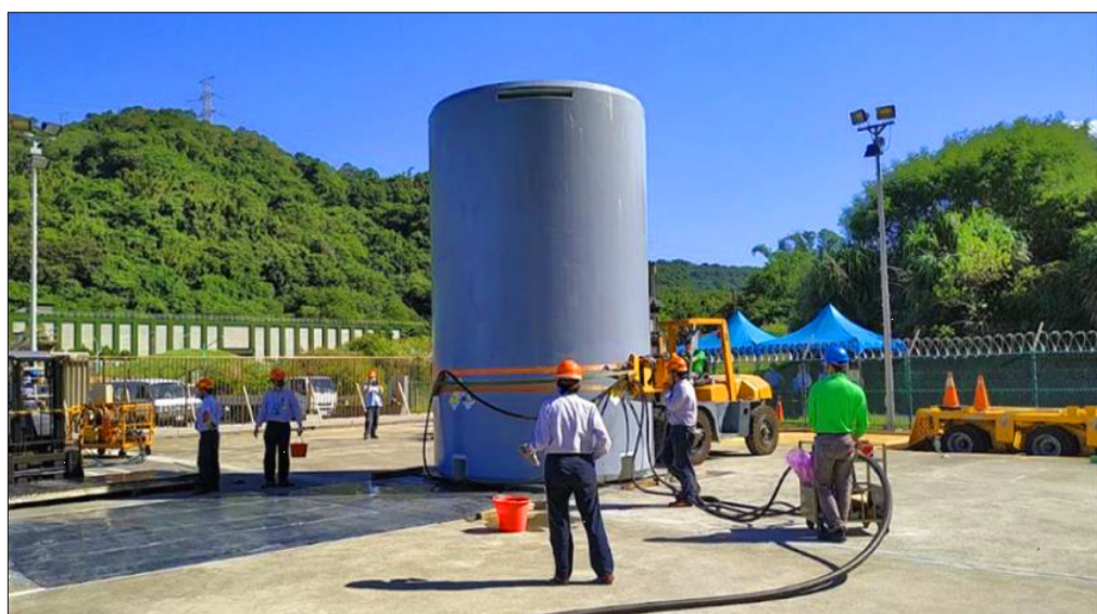
混凝土護箱移動定位作業。
