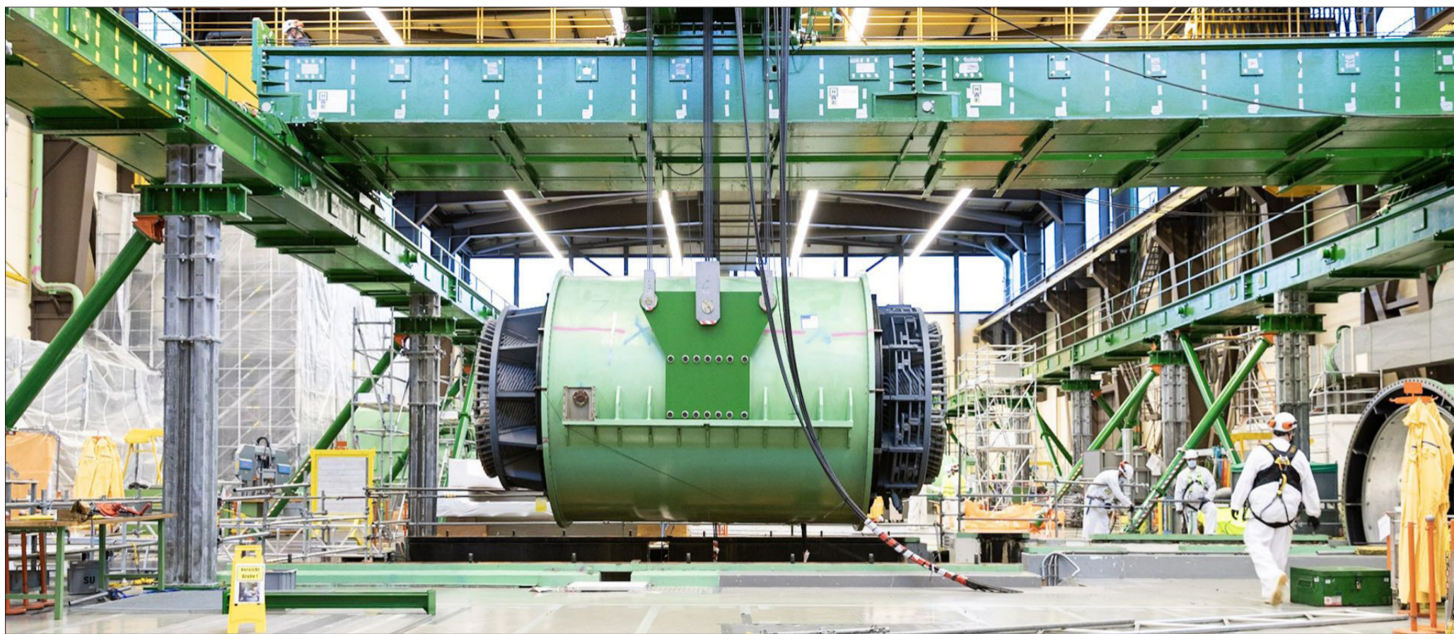
核電廠停機後大型組件拆除作業。
