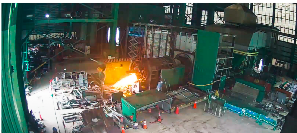
拆除氣渦輪機排氣煙道水平段。
