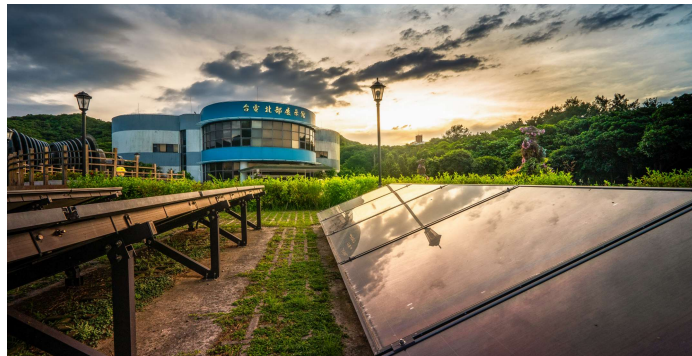
座落於核二廠旁的北部展示館，是台電公司在新北市萬里區的能源教育展館。
