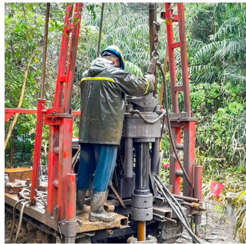
土石堆置場鑽探
