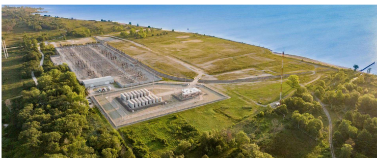
Zion 核電廠除役後的現況
