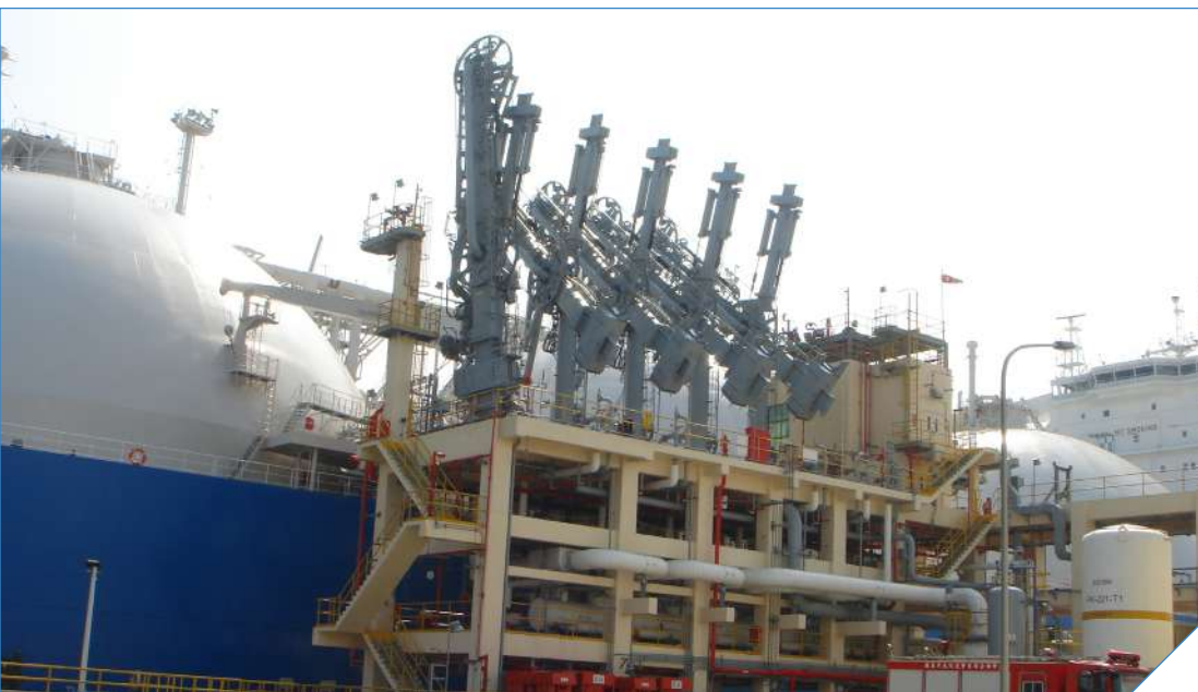
台灣中油公司 LNG 台中接收站
