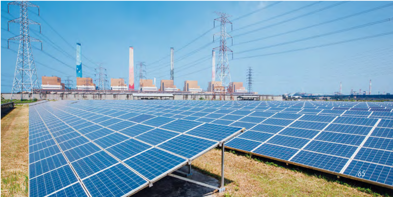
台電臺中龍井太陽光電站
