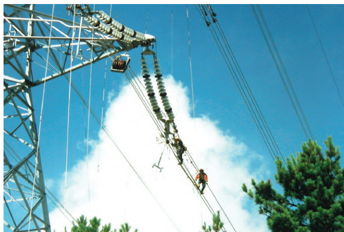
► 台電公司輸電線路架線作業
