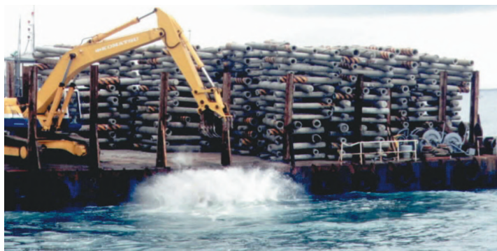
▶ 利用退廢水泥電桿轉製作成人工魚礁
