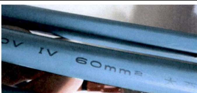
接地線徑(接地棒或接地板之接地引接線)
