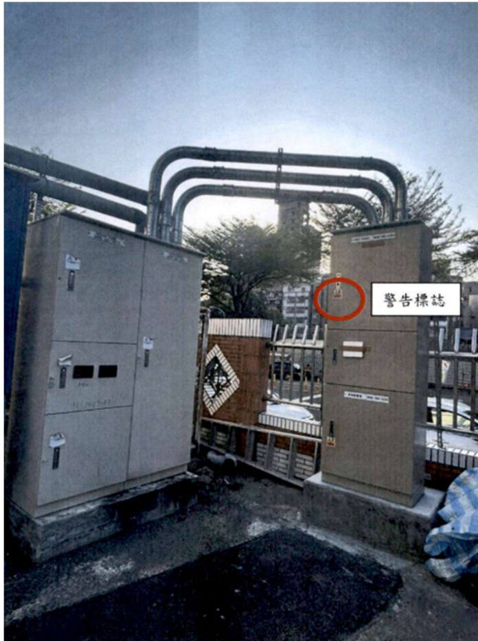
責任分界點(拼接點)與電表箱(外觀)之合照 (警告標示)
