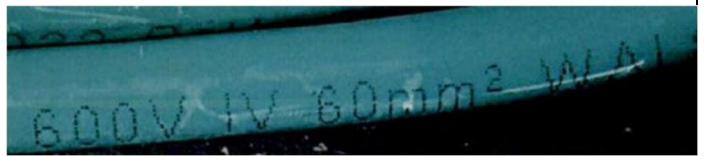
AC 或 MP 盤接地線徑
