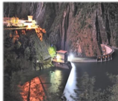
大甲溪發電廠
