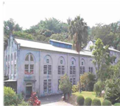
高屏發電廠 (竹門機組)
