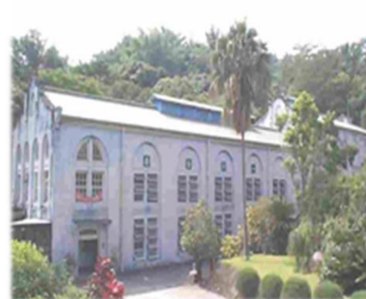
高屏發電廠 (竹門機組)
