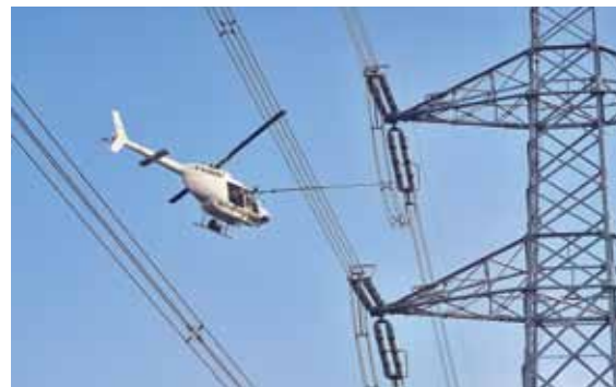
空中作業 / 梁展誌 攝
