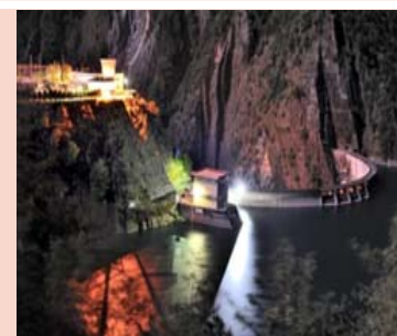
大甲溪發電廠
