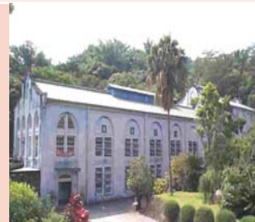
高屏發電廠(竹門機組)
