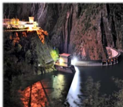
大甲溪發電廠
