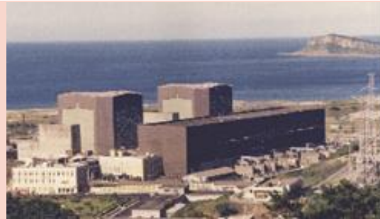
第二核能發電廠
