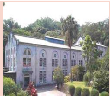
高屏發電廠(竹門機組)
