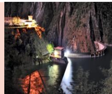
大甲溪發電廠
