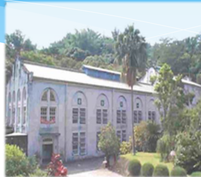
高屏發電廠 (竹門機組)
