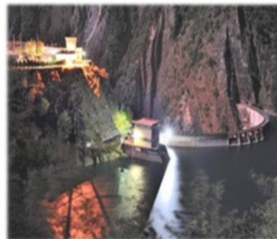
大甲溪發電廠
