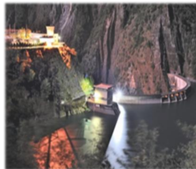
大甲溪發電廠
