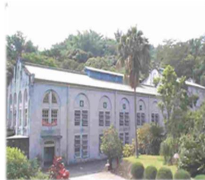
高屏發電廠 (竹門機組)
