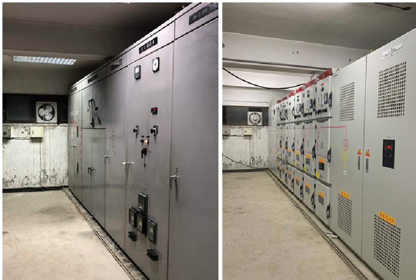
圖 1 鳳山區處高壓變電站改建前(左)後(右)
