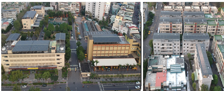
圖 2 太陽光電建置鳳山區處(600kWp)，乙種鳳山宿舍 7 棟(200kWp)
