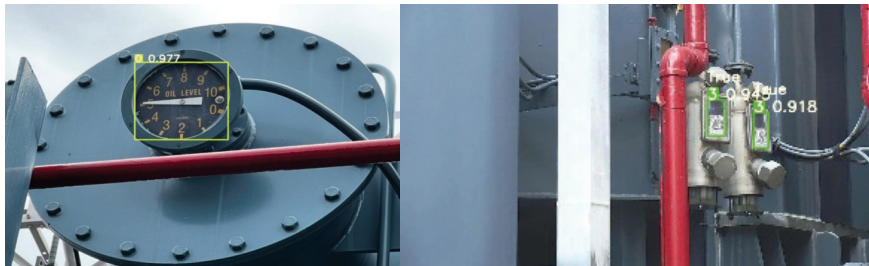
圖 2 油位計與呼吸器的儀表指針數值
