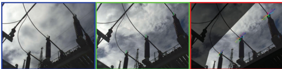
圖 3 ABS 空斷開關的指示標角度
