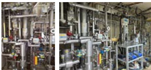
圖 1 富液分流管線與 CABS 設備
