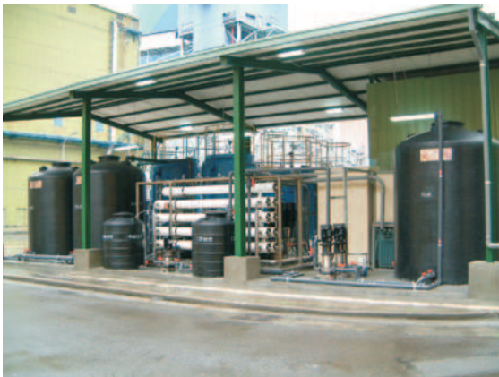
圖 3 逆滲透膜廢水回收系統設備外觀
