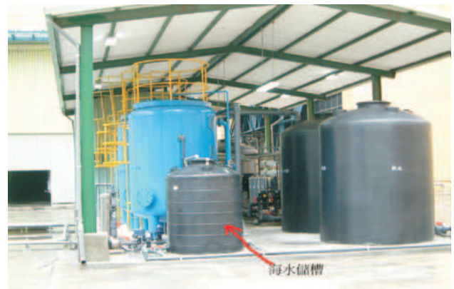
圖 6 軟化槽再生用海水儲槽
