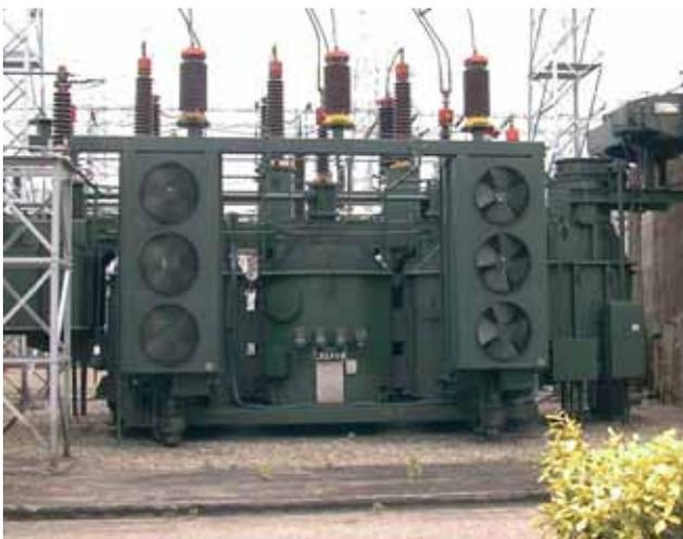
一次壓變電所(P/S) 200 MVA 161kV/69kV/11kV 電力變壓器
