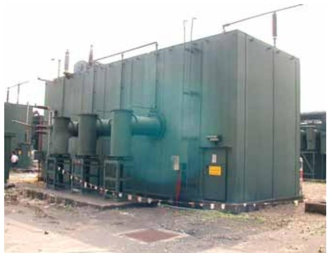
密封型 161/69/11kV 主變壓器
