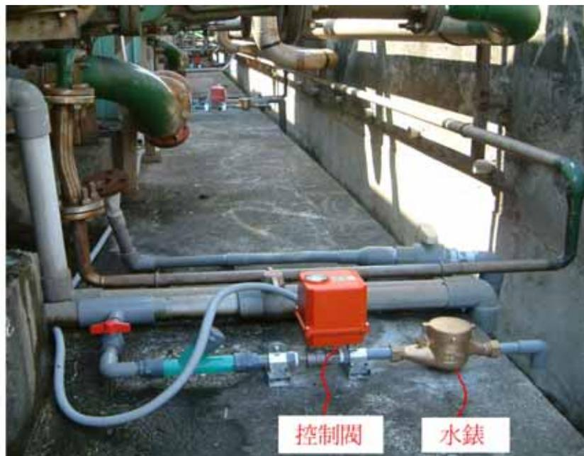
圖2. 冷卻水塔之自動沖放系統
