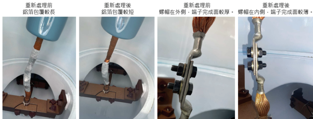
圖 1 高壓引出線端子接續
