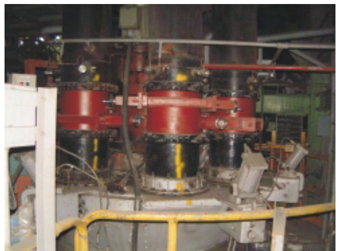
圖1 粉煤分管加裝「可調式節流閥」
