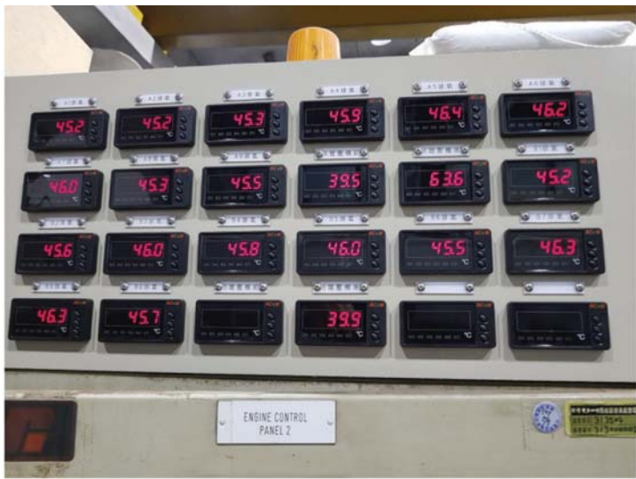
圖 2 控制盤溫度表箱面板實際安裝
