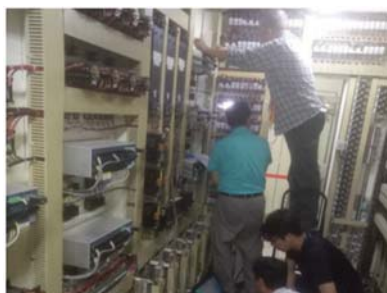
台中發電廠 9 號機大修控制室 電氣儀表試驗
