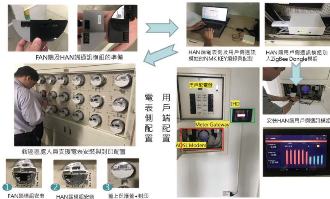
圖 2 Route B 系統現場安裝流程
