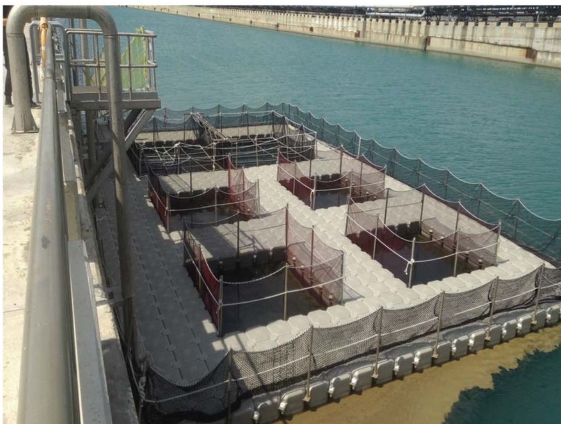
圖 2 脫硫海水渠道箱網 (圖說) 於脫硫海水渠道建置海洋牧場箱網進行養殖試驗。
