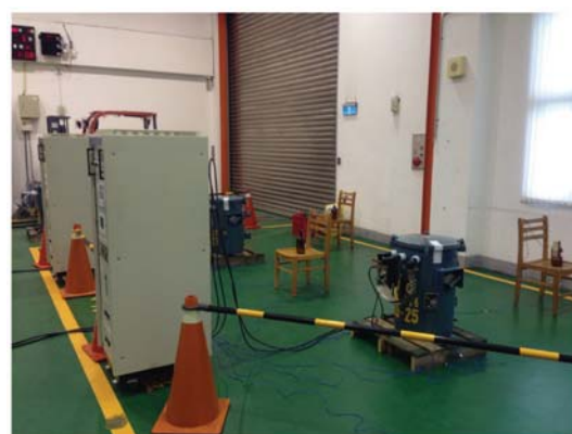
配電變壓器溫升試驗
