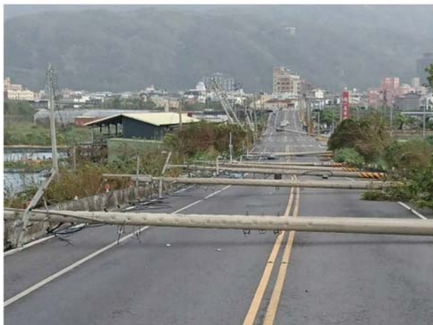
圖 1 尼莎颱風造成頭城海邊倒桿圖
