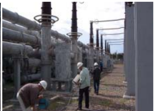
圖 2. 核三廠避雷器現場檢測
