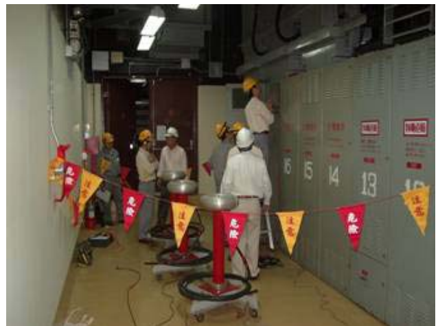
圖二、緊要匯流排突波試驗
