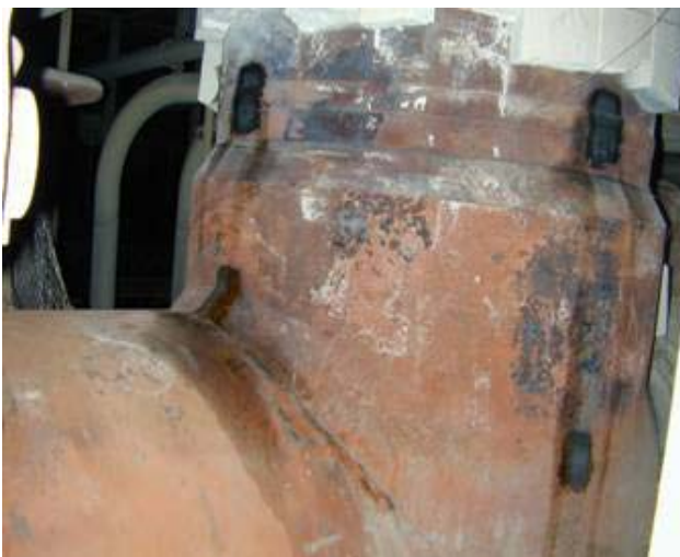
圖一、過熱器出口集管現場複製膜取樣
