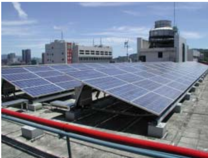
圖一、太陽電池模板架設完成
