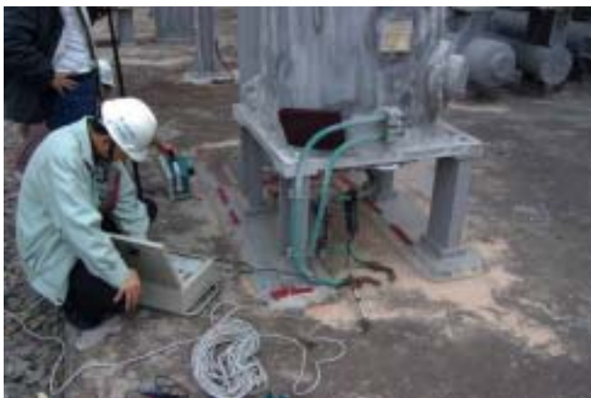
圖 1. 核三廠避雷器現場檢測
