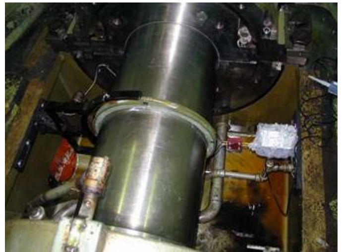
圖二、台中電廠#5機之扭振測試
