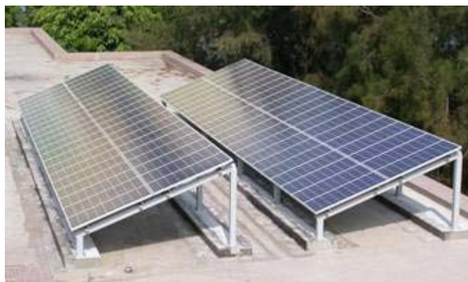
圖一、太陽電池模板架設完成圖
