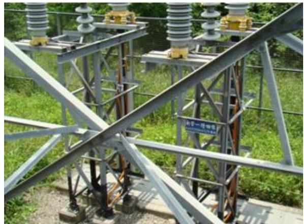
圖2、69kV電纜連接站台架
