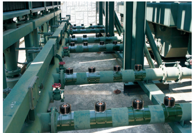
圖 4 變壓器絕緣油油管加裝熱導管
