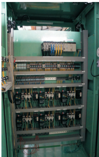
圖 3 控制箱實體內部配置
