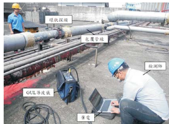
圖 2 現場導波檢測
