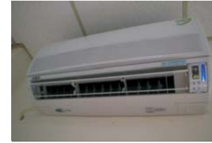
分離式冷氣機
