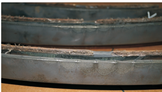
圖 1 產生熱疲勞龜裂之內氣封照片
