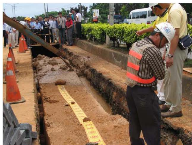
圖4 CLSM澆置於管溝實況
