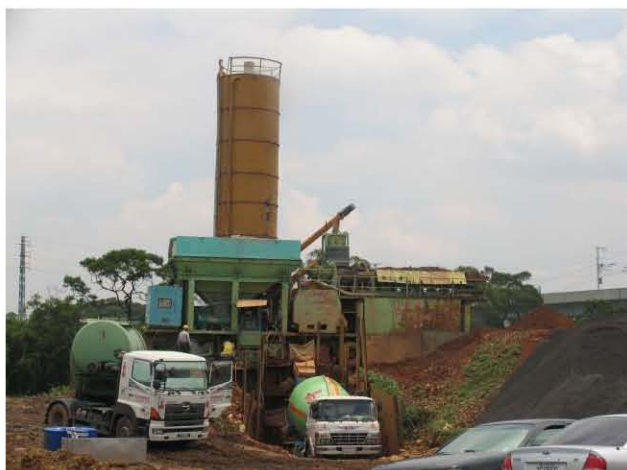
圖3 自走式拌和機作業情形
