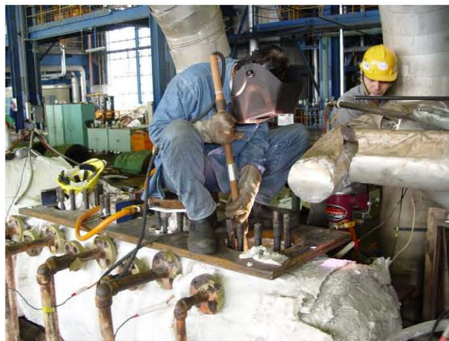
圖2 實際閥座進行手工電鐸施鐸之外觀
