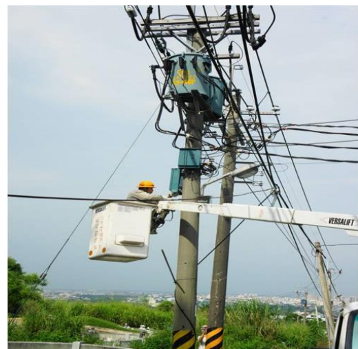
圖2 量測收集單體施工照片
