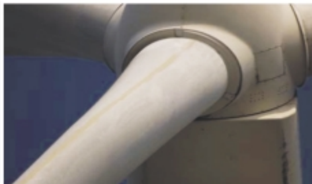
圖 2 葉片表面膠殼沖蝕、劣化變黃等損壞
