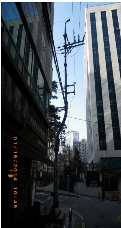
圖 1 韓國電力公司特殊造型電桿實境
