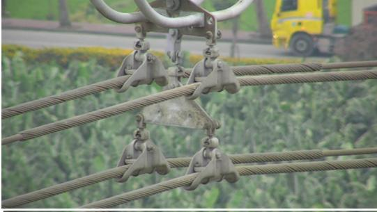
圖 3 可見光進行鐵塔配件設備外觀檢查
