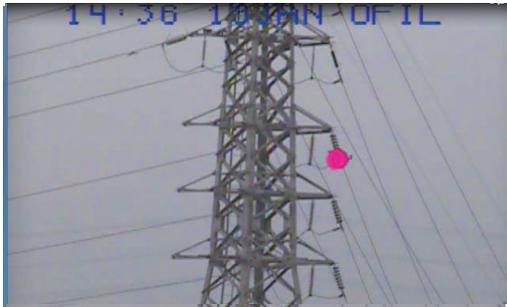
圖 5 紫外光儀檢測礙子發生表面放電案例
