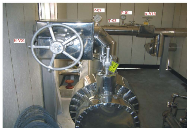
圖 2 加熱系統相關控制閥、溫度表與壓力表位置(貨櫃內)
