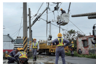
新塹 S/S 69kV 新塹 ~ 永華線搶修對相試驗 (114/07)
