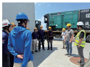
星能公司七股昇壓站 (星光光 G/S) 遞昇加 壓試驗 (114/04)
