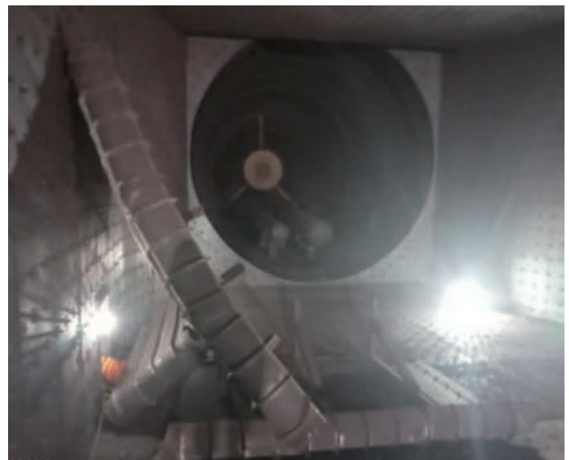
圖 2 爐前抵板掉落照 (鍋爐內部)
