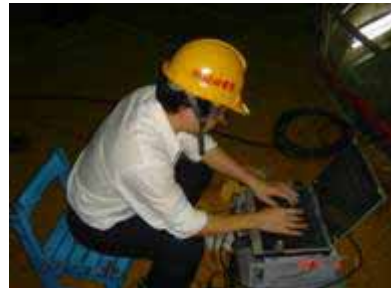
水簾機組發電機部份放電試驗
