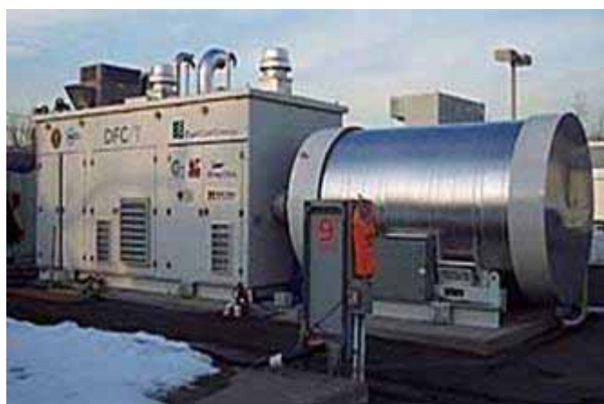
圖1、FCE公司250kW (MCFC) 與60kW MT混合型示範系統 圖2、世界上第一台220kW (SOFC) /MT混合型示範系統
