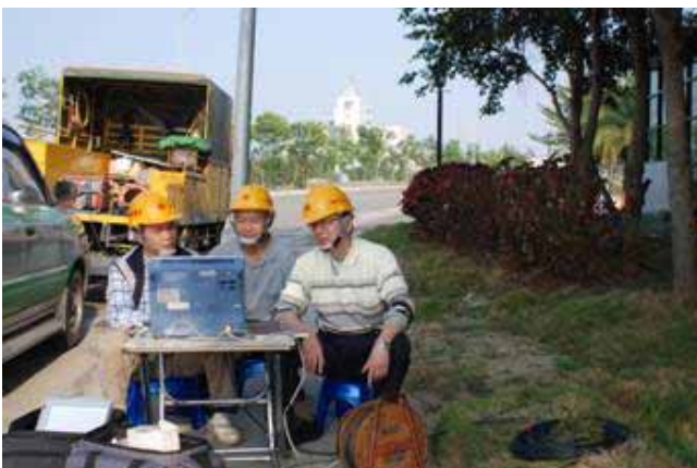
圖1、地下電纜系統之線上PD檢測作業
