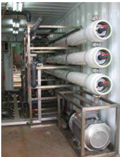
圖1、逆滲透膜與海水高壓泵
