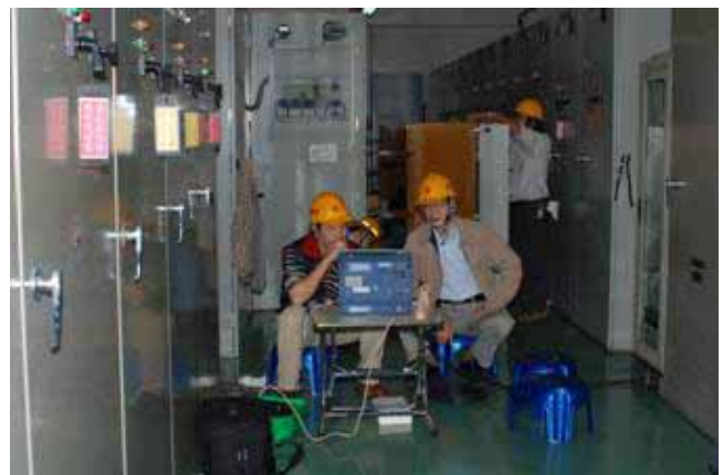
圖2、MCSG之中壓電纜線上PD檢測作業
