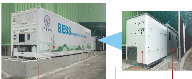
圖 1 1MW/1.5MWh 貨櫃式鋰離子電池儲能系統示意圖
