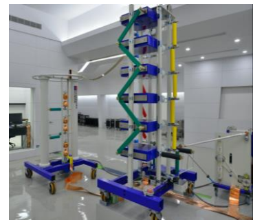
高電壓校正實驗室 High-volt Calibration Lab
