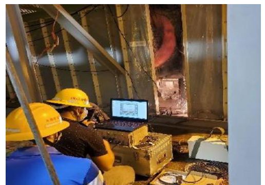
發電機部分放電試驗 Generator Partial Discharge Test
