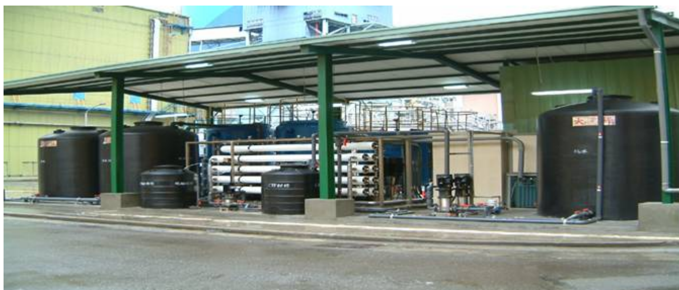
25(噸/小時)產水之逆滲透膜廢水回收系統設備外觀
