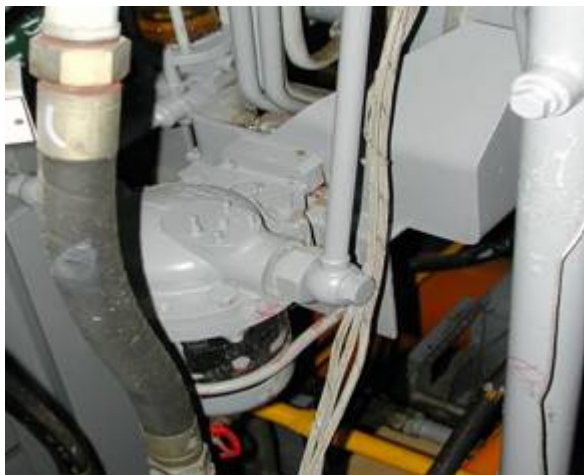
圖1、空氣過濾器及其支撐結構之相關位置照片
