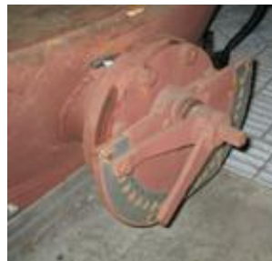
圖2、固定式縮流孔及分煤器出口檔板(下圖)
