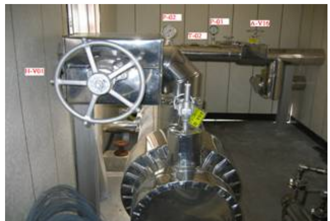
圖2、加熱系統控制閥、溫度表與壓力表 (貨櫃內)
