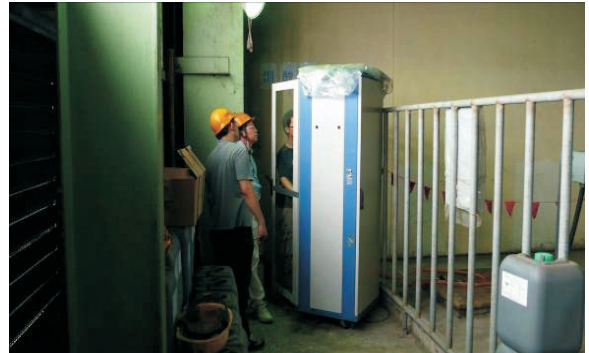
圖 2 現場之腐蝕速度計外觀
