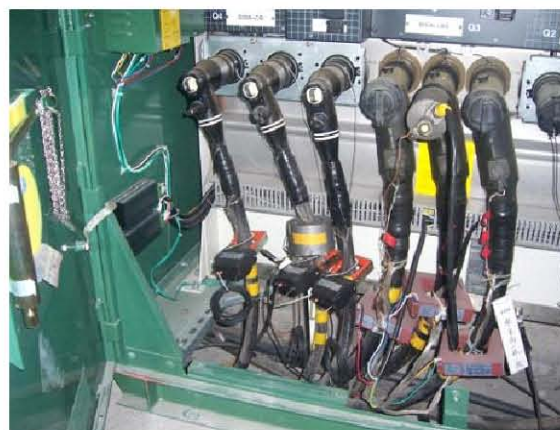
圖3 系統耦合器安裝
