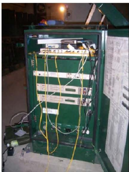
圖2 系統頭端設備
