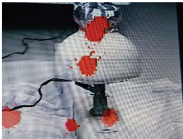
圖 2 絕緣披覆型輕鋼橫擔於 22kV 下紫外光放電影像
