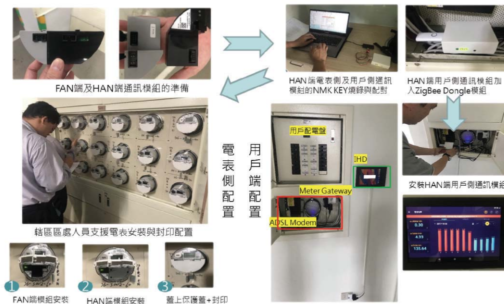
圖 2 Route B 系統現場安裝流程
