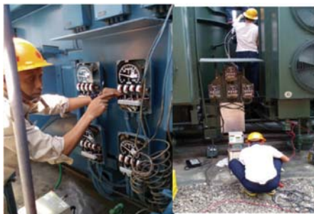
霧峰 E/S 主變壓器溫度開關試驗服務
