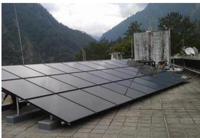
圖1、谷訓中心薄膜型12kWp太陽光電示範系統
