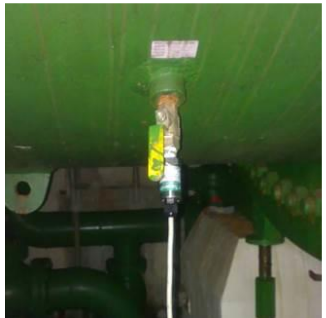
圖 2、置於壓力鋼管之水壓計。
