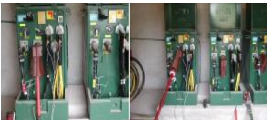
圖2 配電變壓器的高低壓量測接線
