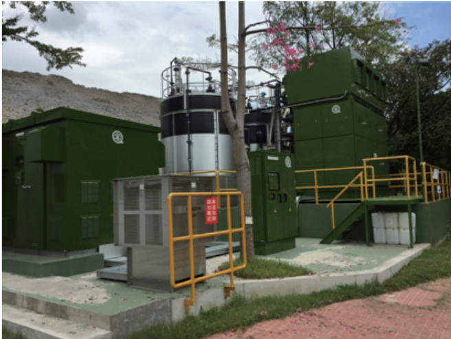
圖 2 液流電池外觀與系統架構
